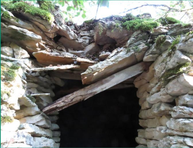
*Cadole n°19 à Gyé-sur-Seine, cas de rupture d'un linteau en pierre. A noter un deuxième en bois possiblement posé en renfort*
