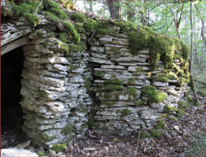
*Cadole n° 19 à Gyé-sur-Seine, à noter les maçonneries de soutènement désolidarisées ou sans harpage. Il s'agit par ailleurs d'une cadole en grand risque d'effondrement à cause de la faiblesse du linteau*
